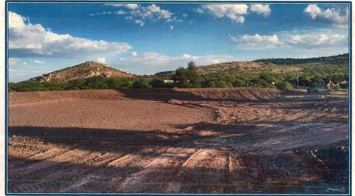
REHABILITACIÓN DE BORDO DE ABREVADERO POB. VICENTE SUAREZ
