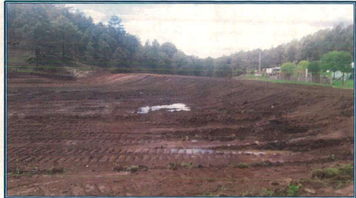
CONSTRUCCIÓN DE BORDO DE ABREVADERO POB. GRAL DOMINGO ARRIETA
