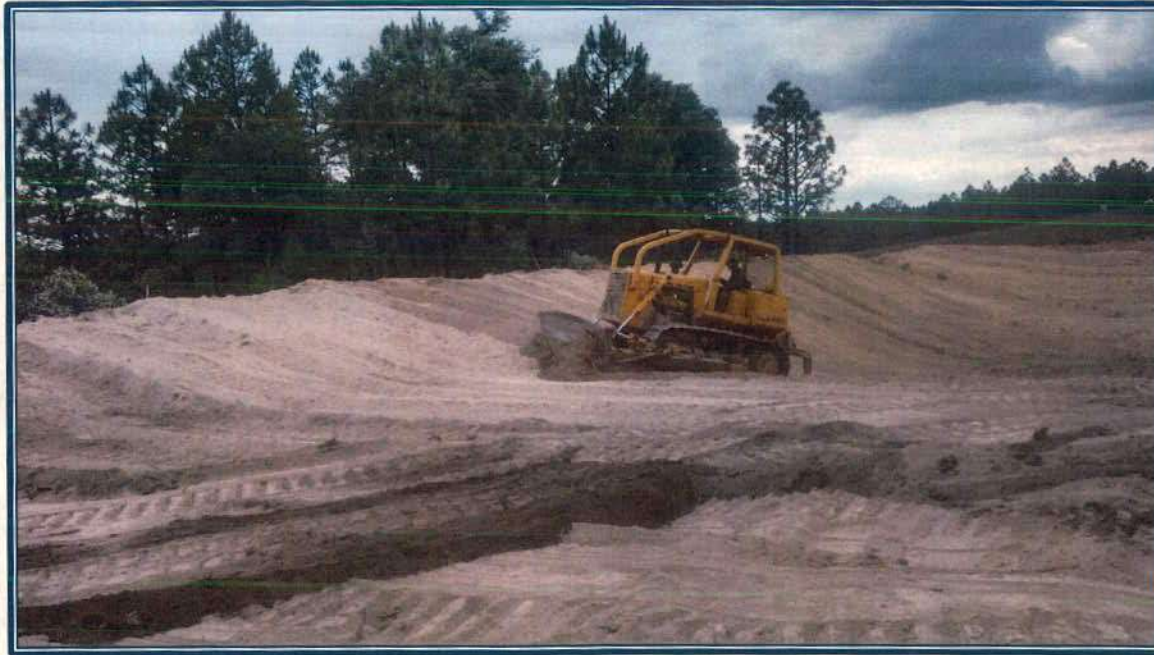
CONSTRUCCIÓN DE BORDO DE ABREVADERO POB. LOS LOBOS
