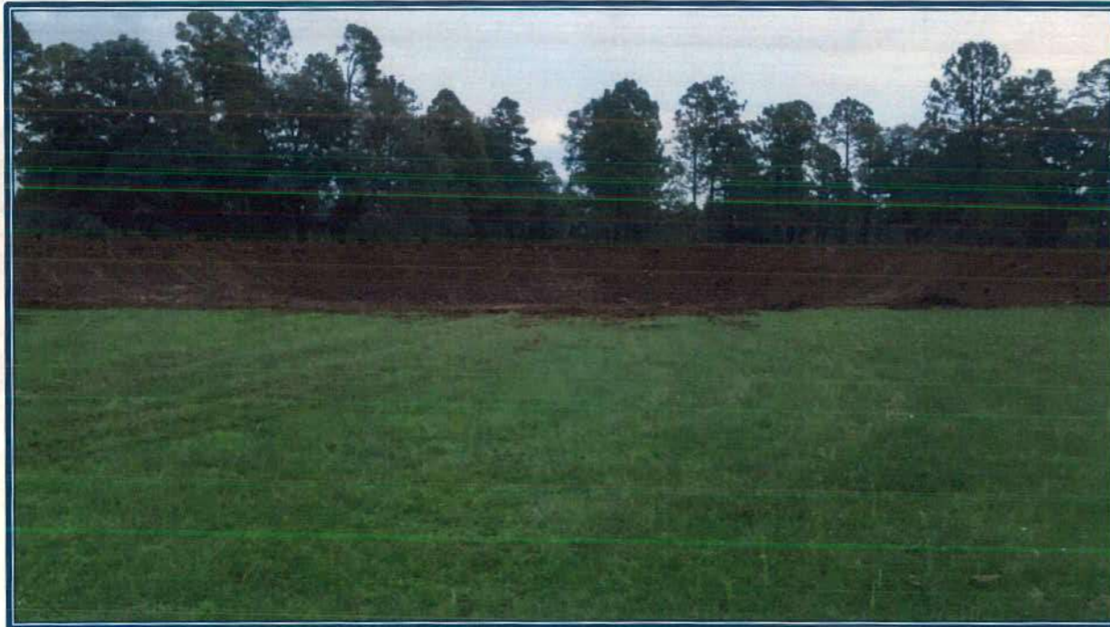
CONSTRUCCIÓN DE BORDO DE ABREVADERO POB. EL MADROÑO
