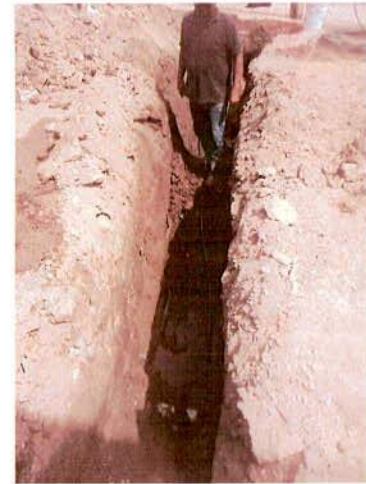
TOMAS DOMICILIARIAS EN LA CALLE COAHUILA; ENTRE C. MÉXICO Y 10 DE FEBRERO COL. MEXICO
