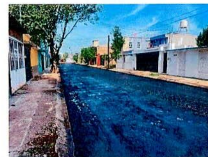
PAVIMENTACIÓN DE LA CALLE LAS CALANDRIAS; ENTRE C. PASEO DE LOS FLAMINGOS Y PASEO JILGUEROS FRACC. SILVESTRE REVUELTAS
