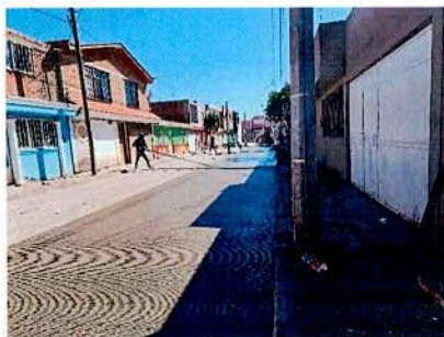
PAVIMENTACIÓN DE LA CALLE COAHUILA; ENTRE C. MÉXICO Y 10 DE FEBRERO. COL. MEXICO
