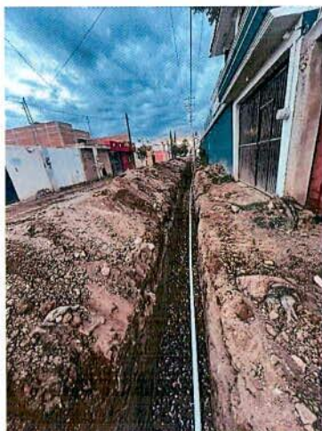
REHAB. DE AGUA POTABLE EN LA CALLE PASEO DE LAS ARBOLEDAS; ENTRE C. REAL DEL MEZQUITAL y MEZQUITES COL. VALLE VERDE
