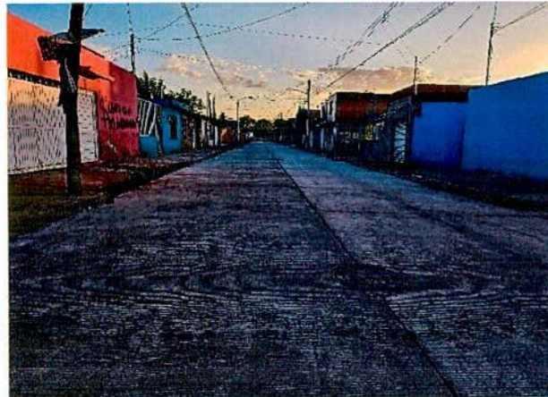
PAVIMENTACIÓN EN LA CALLE 5 DE FEBRERO; ENTRE C. 10 DE MAYO Y C. ARROYO SECO COL. CONSTITUCION
