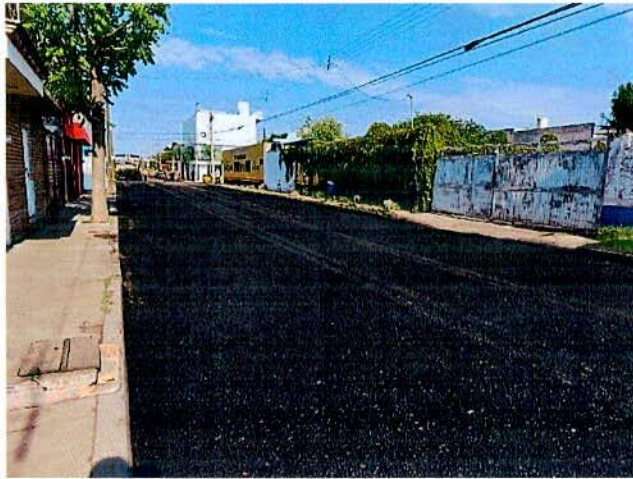
Pavimentación de calle Mascareñas con asfalto entre calle Marlos león de la Peña y calle reforma en Zona Centro, en el Municipio de Durango, en la Localidad de Durango
