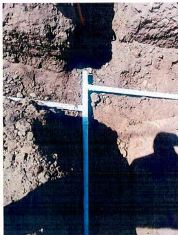
REHAB. DE AGUA POTABLE EN LA CALLE PRINCIPAL; ENTRE ACCESO Y EL CANAL POB. IGNACIO LÓPEZ RAYÓN
