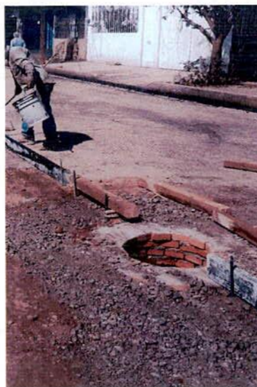
REHABILITACIÓN DE ALCANTARILLADO EN LA CALLE 5 DE MAYO; ENTRE C. INDEPENDENCIA Y MANUEL BUENDÍA "COL. JOSE REVUELTAS"
