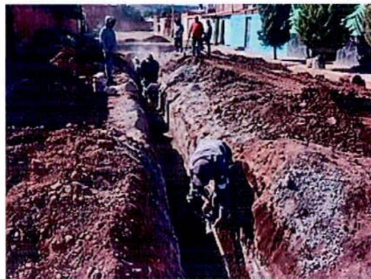
REHABILITACIÓN DE AGUA POTABLE EN LA CALLE DALIA; ENTRE C. JAZMÍN Y CLAVEL COL. PRI AMPLIACION
