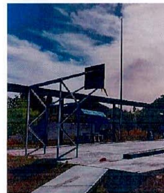
Construcción de Domo en la Cancha de Basquetbol Escuela General Carlos Real CCT 10EPR0061Q, Loc. Morcillo
