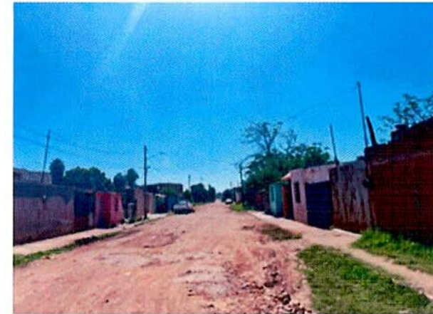
CONSTRUCCIÓN DE GUARNICIONES EN LA CALLE DALIA; ENTRE C. JAZMÍN Y CLAVEL COL. PRI AMPLIACION
