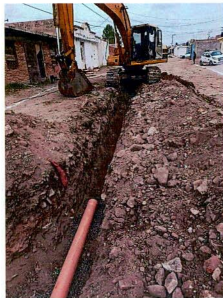
REHABILITACIÓN DE ALCANTARILLADO EN LA CALLE 15 DE MAYO; ENTRE C. LIC. JOSÉ RAMÓN HERNÁNDEZ MERÁZ y 18 DE MAYO COL. AMPLIACION MIGUEL DE LA MADRID
