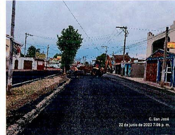
Pavimentación de Calle San José con Asfalto entre Calle México y Calle Hacienda de San Luis en el Fracc. Hacienda de Tapias, en el Municipio de Durango, en la Localidad de Durango
