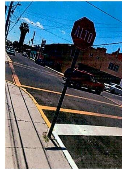
Pavimentación de calle canatlán con asfalto entre calle Educación y calle Sta. María del Oro en la Col. Hipodromo, en el Municipio de Durango, en la Localidad de Durango
