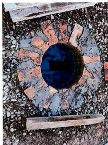
REHAB. DE ALCANTARILLADO EN LA PRIVADA NIÑOS HEROES; ENTRE C. AGUSTÍN MELGAR y JUAN ESCUTIA FRACC. BENITO JUAREZ
