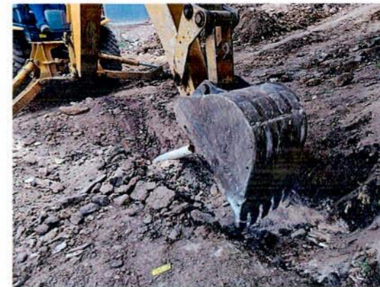
REHABILITACIÓN DE AGUA POTABLE EN LA AVE. JUAN SALAZAR (O PROLONG. LILAS); ENTRE C. ROSAS Y PROLONG. TEMAZCAL COL. JUAN SALAZAR
