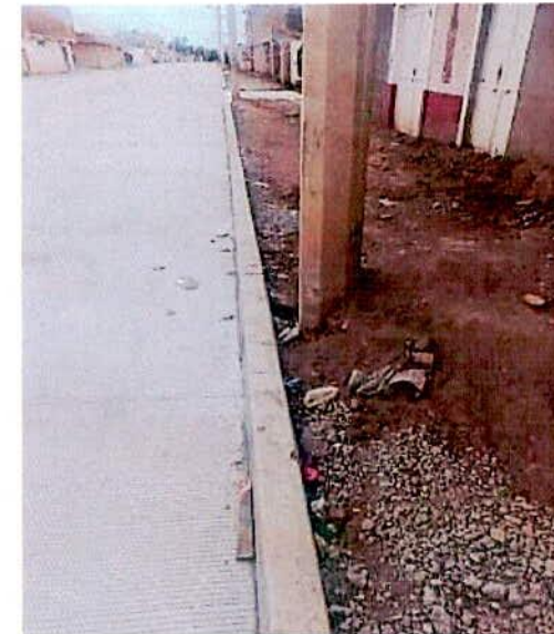
CONSTRUCCIÓN DE GUARNICIONES EN LA AVE. SAN JOSÉ; ENTRE C. SAN VALENTÍN Y SAN JUAN DE LETRÁN COL. SAN JOSE III
