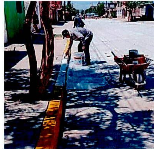
PAVIMENTACIÓN EN LA CALLE FELIPE ANGELES 300; ENTRE C. SAN JUAN DE GUADALUPE Y CESÁREO RODRÍGUEZ COL. JOSE ANGEL LEAL
