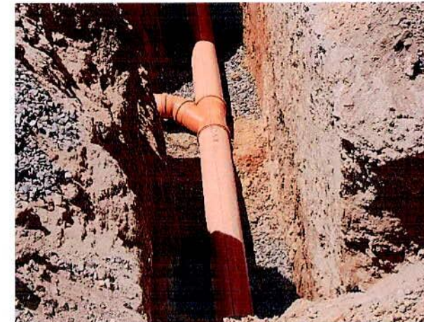
REHABILITACIÓN DE ALCANTARILLADO EN LA CALLE MIRASOL; ENTRE C. ZAFIRO Y C. CAMINO A LA LOMA COL. SAN CARLOS
