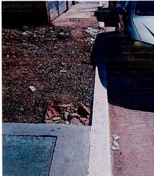
CONSTRUCCIÓN DE GUARNICIONES EN LA CALLE 5 DE FEBRERO; ENTRE C. 10 DE MAYO Y C. ARROYO SECO COL. CONSTITUCION
