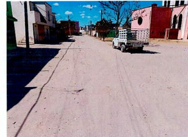
PAVIMENTACIÓN EN LA CALLE COSTA RICA; ENTRE C. NUEVA DELHÍ Y NÁPOLES COL. UNIVERSAL
