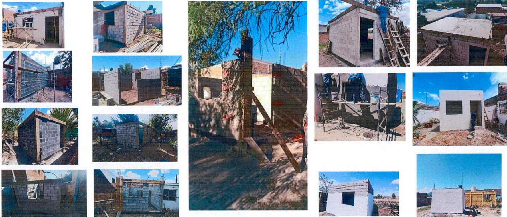
Construcción de Cuarto Urbano en Victoria de Durango
