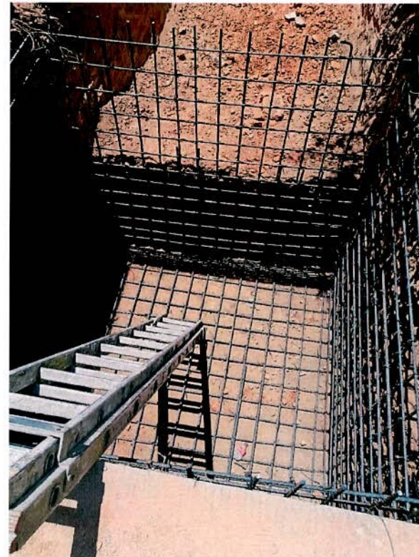
CONSTRUCCIÓN DE POZO DE ABSORCIÓN EN AV. JESÚS GARCÍA COL. JOSÉ REVUELTAS
