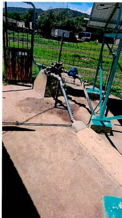
EQUIPAMIENTO FOTOVOLTAICO DE POZO PROFUNDO DE AGUA POTABLE - POB. PRIMERO DE MAYO
