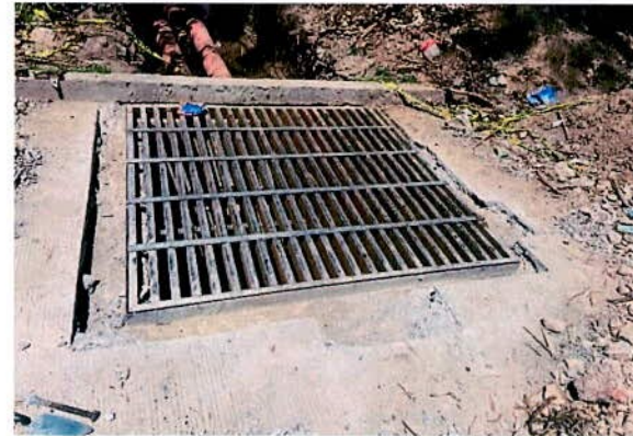
CONSTRUCCIÓN DE POZO DE ABSORCIÓN EN CIRCUITO NIÑOS HEROES 1 COL. JOSE REVUELTAS
