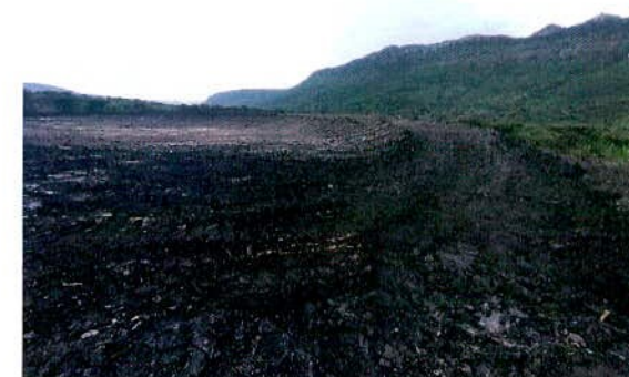
CONSTRUCCIÓN DE BORDO PARA ABREVADERO EN EL POB. SANTIAGO BAYACORA
