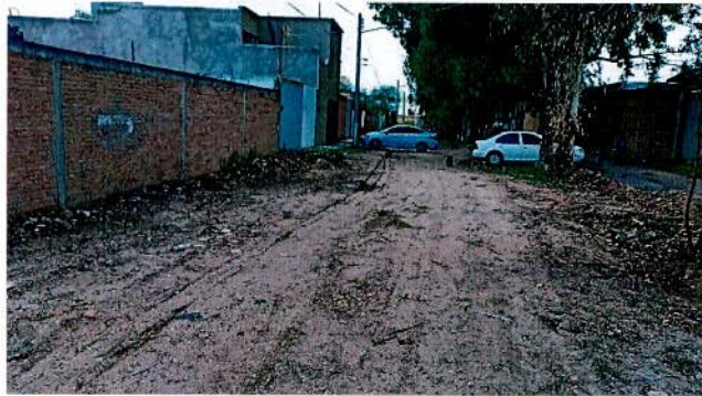
CONSTRUCCIÓN DE RED DE AGUA POTABLE COL.- ALCALDES
