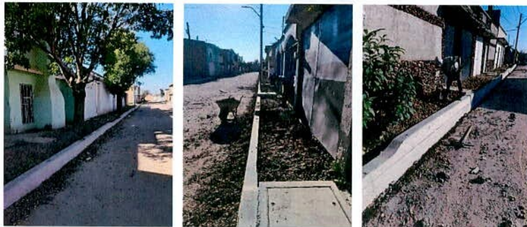
CONSTRUCCIÓN DE GUARNICIONES EN CALLE BEGONIA 100, ENTRE AV. PASEO DE LA FERRERÍA Y VALLE VERDE COL. VALLE VERDE SUR
