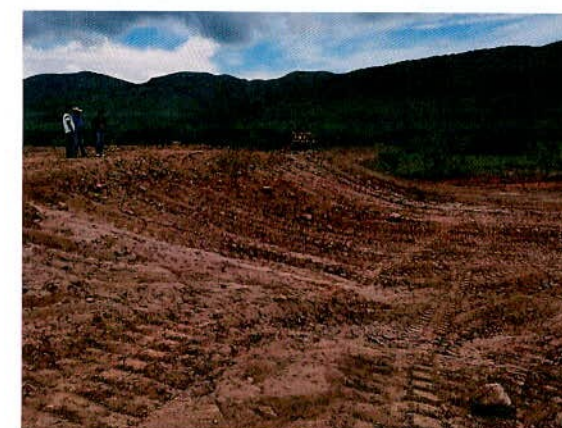
CONSTRUCCIÓN DE BORDO PARA ABREVADERO EN EL POB. JUAN ALDAMA
