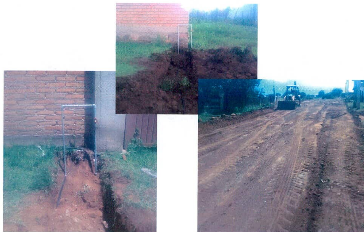
CONSTRUCCIÓN DE LÍNEA CONDUCCIÓN - POB. MAXIMO GARCÍA (EL PINO)
