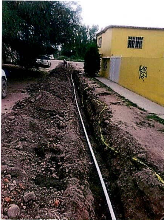
CONSTRUCCIÓN DE LÍNEA CONDUCCIÓN - POB. CONTRERAS
