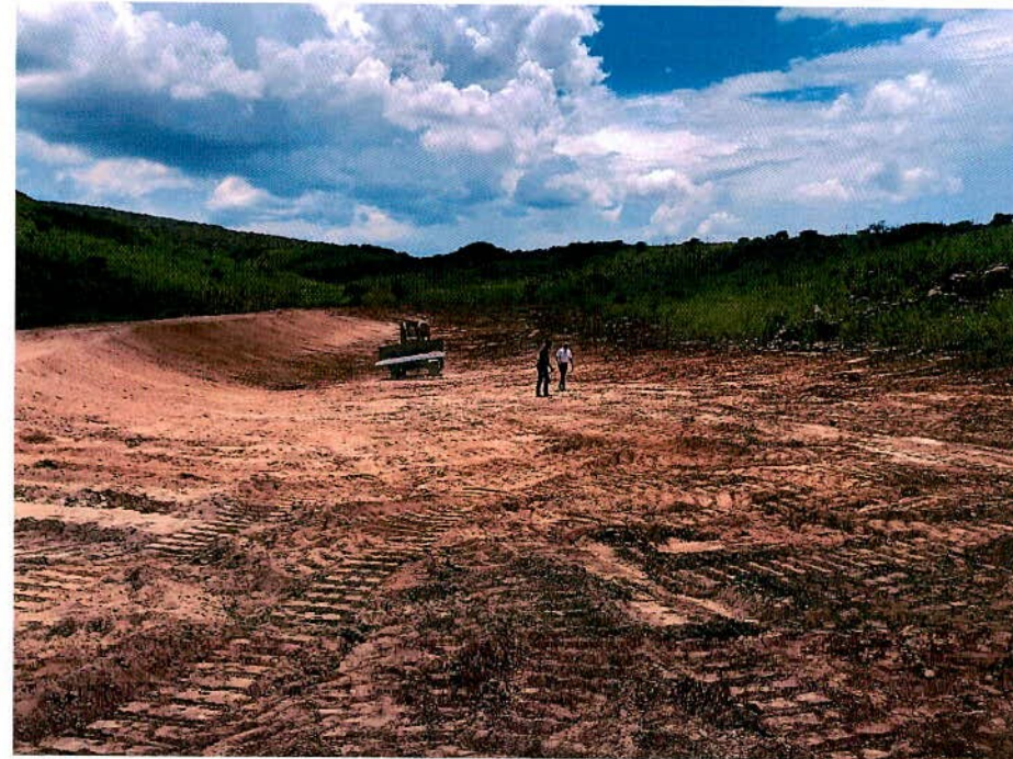
CONSTRUCCION DE BORDO DE ABREVADERO EN EL POB. PILAR DE ZARAGOZA
