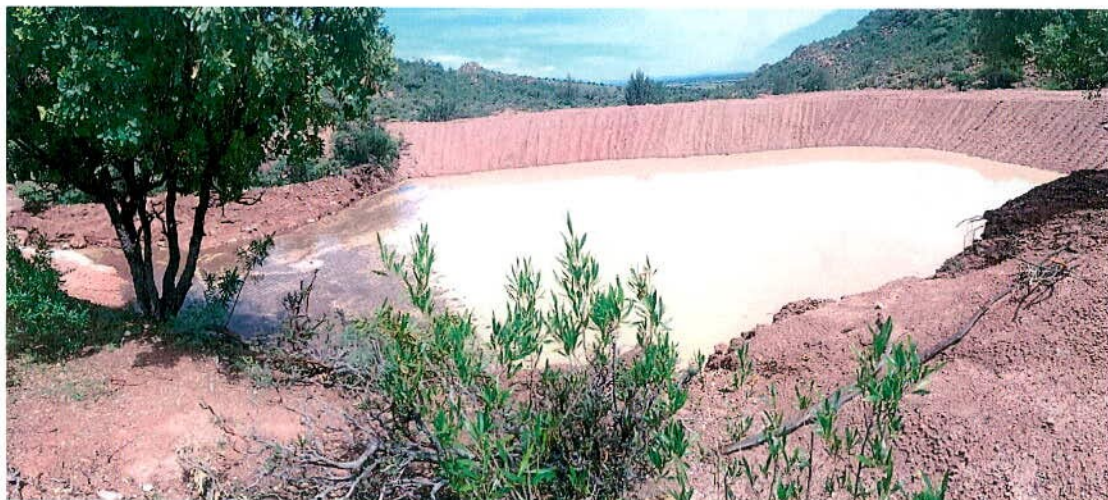
CONSTRUCCIÓN DE BORDO PARA ABREVADERO POB. MORCILLO
