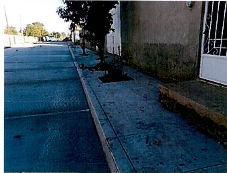
CONSTRUCCIÓN DE GUARNICIONES EN CALLE JOSÉ RAMÓN ESTRADA, ENTRE ESCARCHA Y RANCHO GRANDE COL. MASIE
