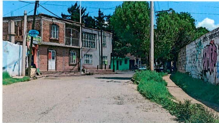
REHABILITACIÓN DE RED DE ALCANTARILLADO COL. SERGIO MÉNDEZ ARCEO
