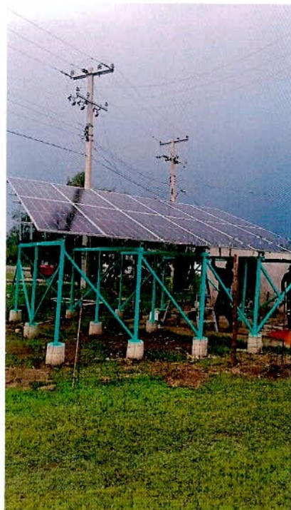
EQUIPAMIENTO FOTOVOLTAICO DE POZO PROFUNDO DE AGUA POTABLE - POB. PRIMERO DE MAYO
