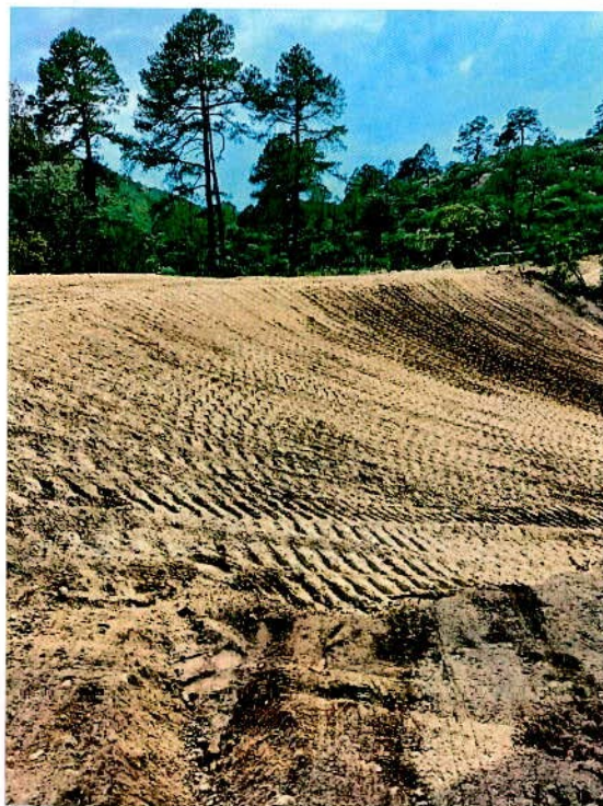
CONSTRUCCIÓN DE BORDO PARA ABREVADERO POB. PTE. SALVADOR ALLENDE
