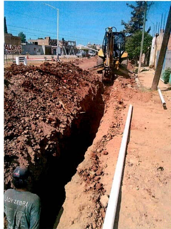
AGUA POTABLE EN CALLE SILVESTRE REVUELTAS, ENTRE PROLONG. BLVD. DE LAS ROSAS Y GUANACEVÍ COL. JOSÉ ÁNGEL LEAL
