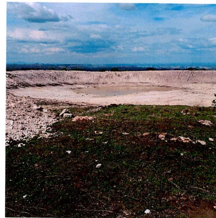
CONSTRCCIÓN DE BORDO PARA ABREVADERO EN EL POB. 16 DE SEPTIEMBRE
