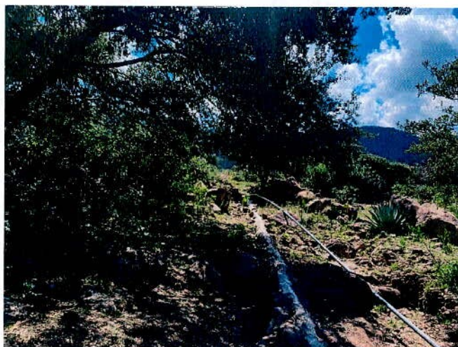
REHABILITACIÓN DE LÍNEA DE CONDUCCIÓN - POB. VALLE FLORIDO
