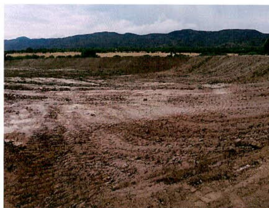
CONSTRUCCIÓN DE BORDO PARA ABREVADERO EN EL POB. HÉROES DE NACOSARI
