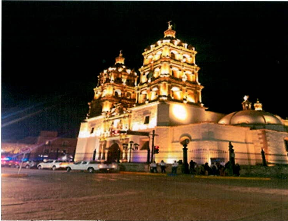
REMODELACIÓN DEL ALUMBRADO ORNAMENTAL DE LA CATEDRAL DE DURANGO
