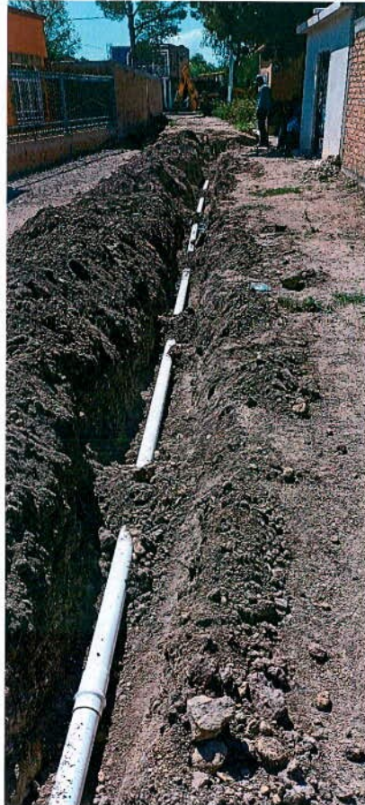
CONSTRUCCIÓN DE LÍNEA CONDUCCIÓN - POB. CINCO DE FEBRERO
