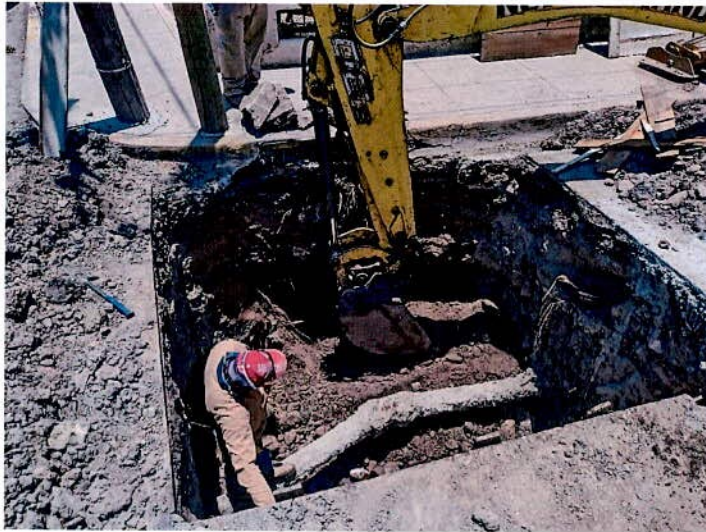
CONSTRUCCIÓN DE POZO DE ABSORCIÓN EN AV. FCO. SARABIA FRENTE A BIBLIOTECA CASA DEL ÁRBOL BARRIO DE ANALCO
