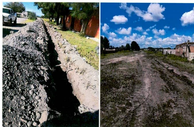
LÍNEA DE CONDUCCIÓN POBLADO 27 DE NOVIEMBRE
