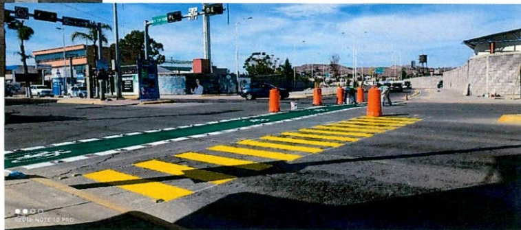
CONSTRUCCIÓN DE CICLOPISTA LAUREANO RONCAL ENTRE BLVD. FELIPE PESCADOR Y EL BLVD. GÓMEZ MORÍN
