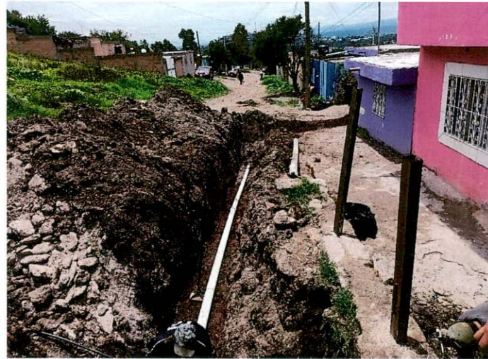
REHABILITACIÓN DE RED DE AGUA POTABLE EN CALLE 5 DE MAYO
