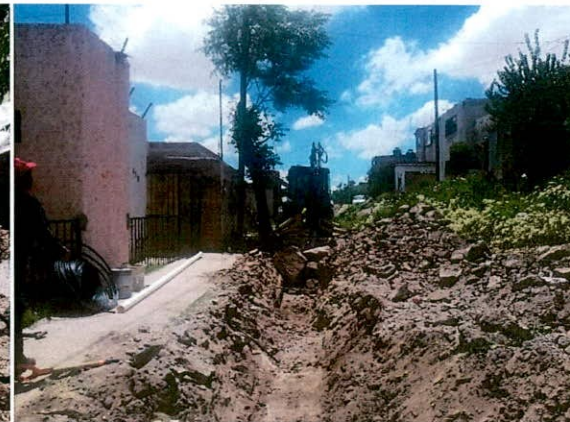
AMPLIACIÓN DE RED DE AGUA POTABLE COL. CERRO DE GUADALUPE
