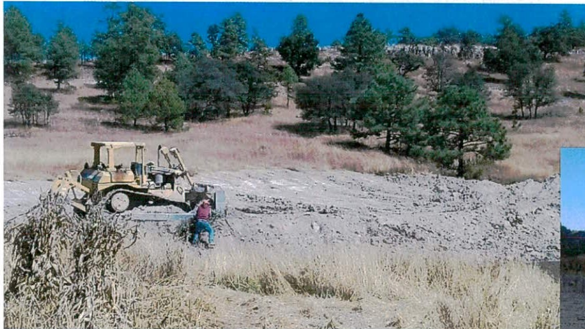
REHABILITACIÓN DE BORDO
