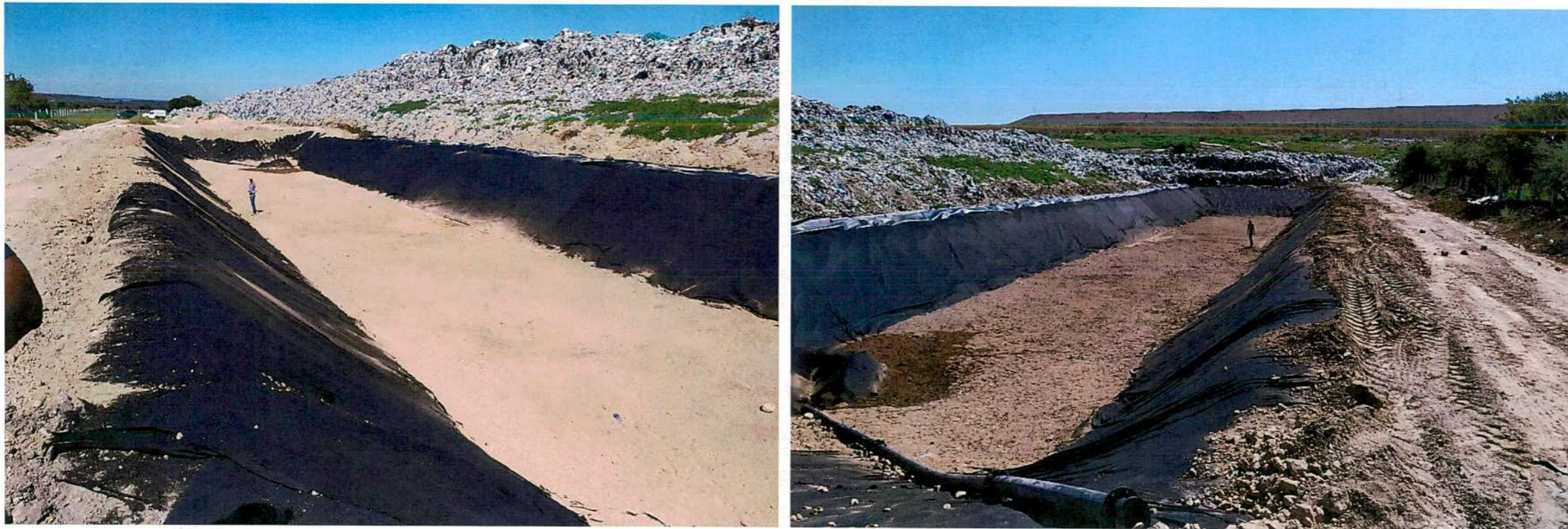
CONSTRUCCIÓN DE CELDA EMERGENTE DEL RELLENO SANITARIO
