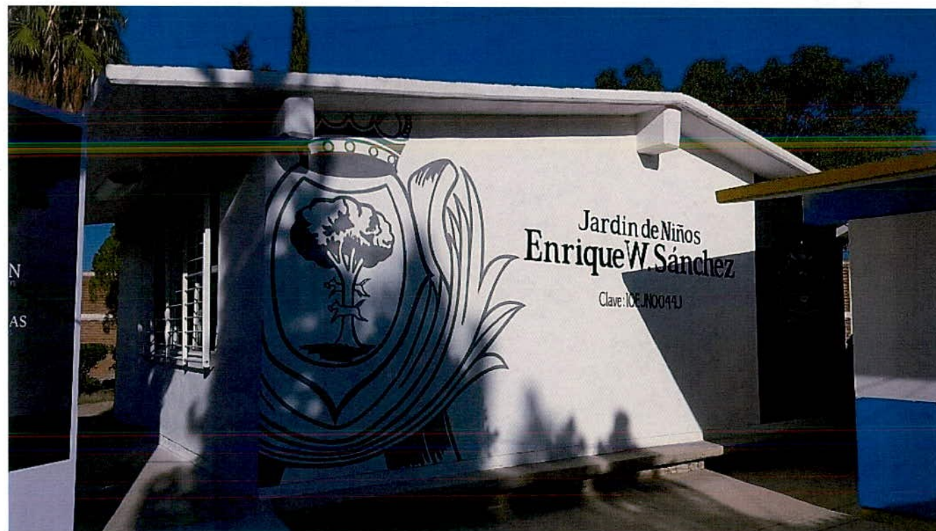
CONSTRUCCIÓN DE AULA J.N. ENRIQUE W. SÁNCHEZ COL. JARDINES DE CANCÚN
