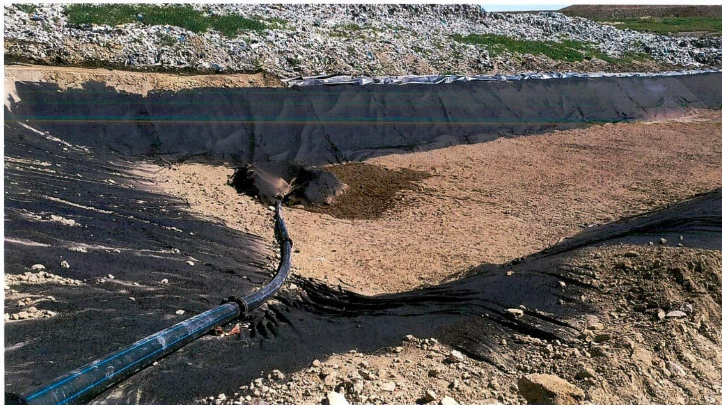
CONSTRUCCIÓN DE CELDA EMERGENTE DEL RELLENO SANITARIO
