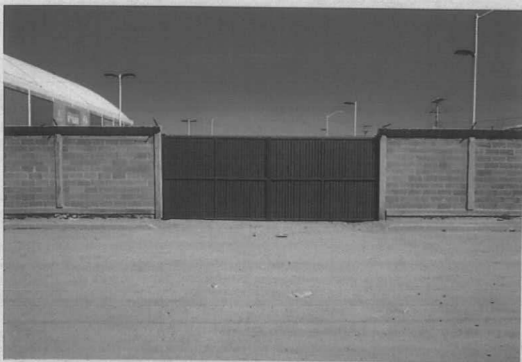
BARRA PERIMETRAL CERRADA GIMNASIO
