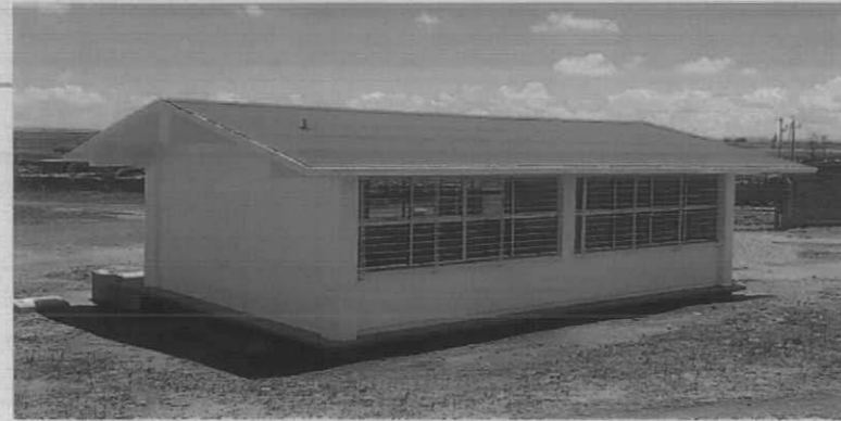
AULA AISLADA EN TELEBACHILLERATO COMUNITARIO POB. EL PINO
