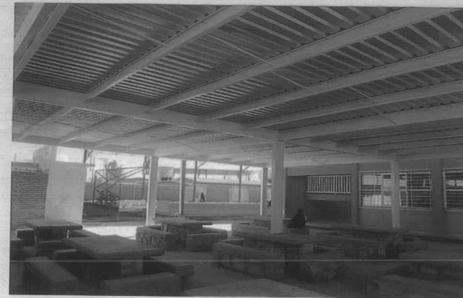
CONSTRUCCIÓN DE CUBIERTA, BARRA PERIMETRAL Y OBRA EXTERIOR DE COMEDOR EN LA ESC. PRIM. "UNIÓN FRATERNIDAD Y LUCHA" COL. AMPL. LUZ DEL CARMEN
