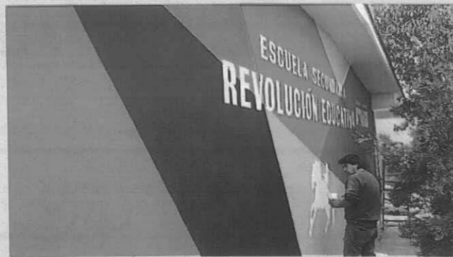
AMPLIACION Y REMODELACION DE BAÑOS EN LA ESC. SEC. "REVOLUCION EDUCATIVA" CLAVE 10EES0048P COL. JUAN LIRA
