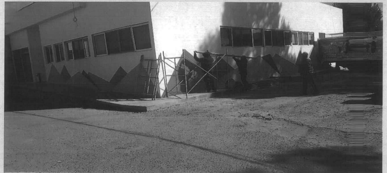
REMODELACION Y AMPLIACION DE CENTRO DE ATENCION ANIMAL (IIa ETAPA)
