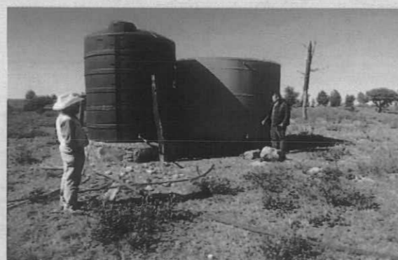
EQUIPAMIENTO DE POZO
