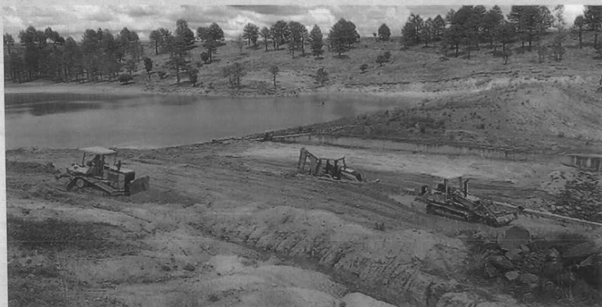
REHABILITACIÓN DE PRESA POB. SAN PEDRO DE LA MAQUINA
