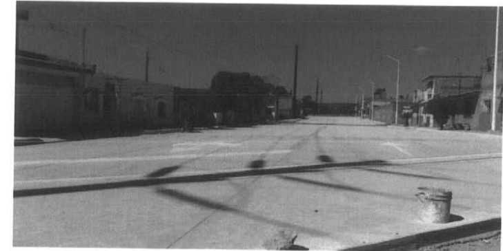
CONSTRUCCIÓN DE VIALIDAD EN COAHUILA COL. MORGA
