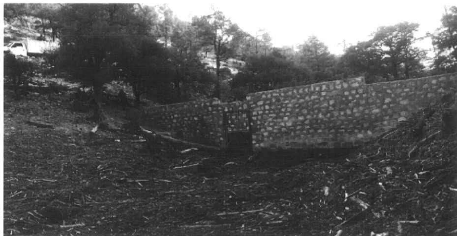
REHABILITACIÓN DE PRESA
