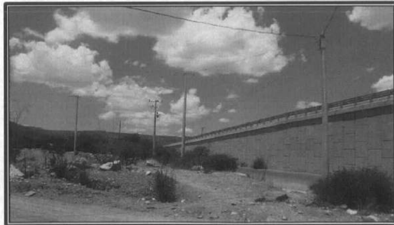
RED DE ELECTRIFICACIÓN POB. LA FERRERÍA
