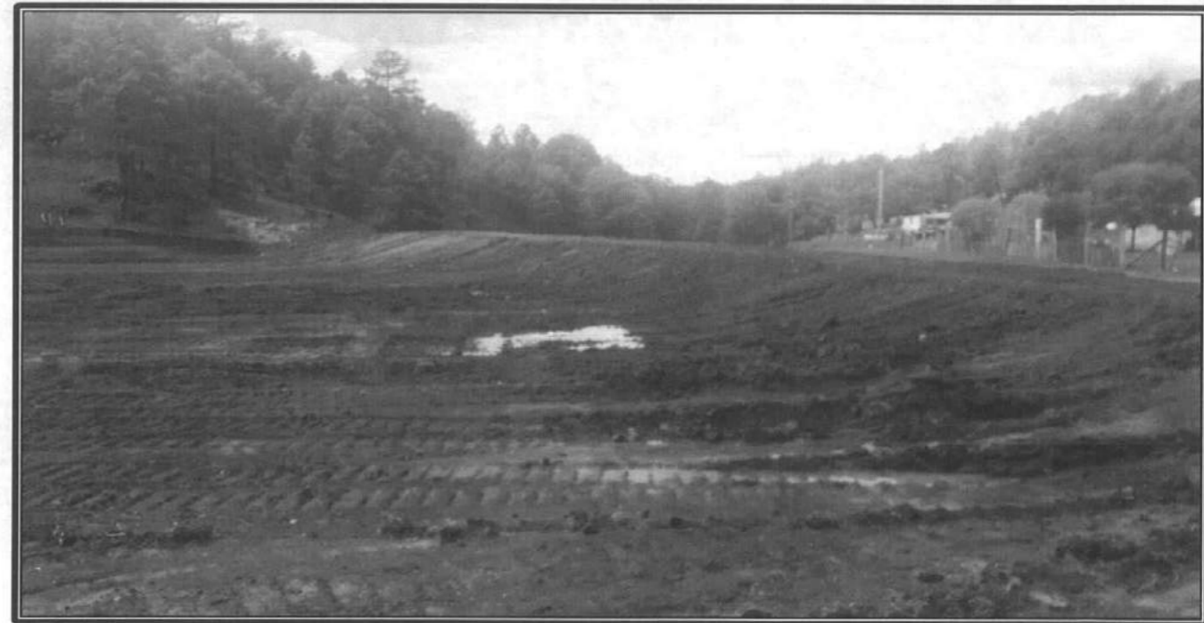
CONSTRUCCIÓN DE BORDO DE ABREVADERO POB. GRAL DOMINGO ARRIETA
