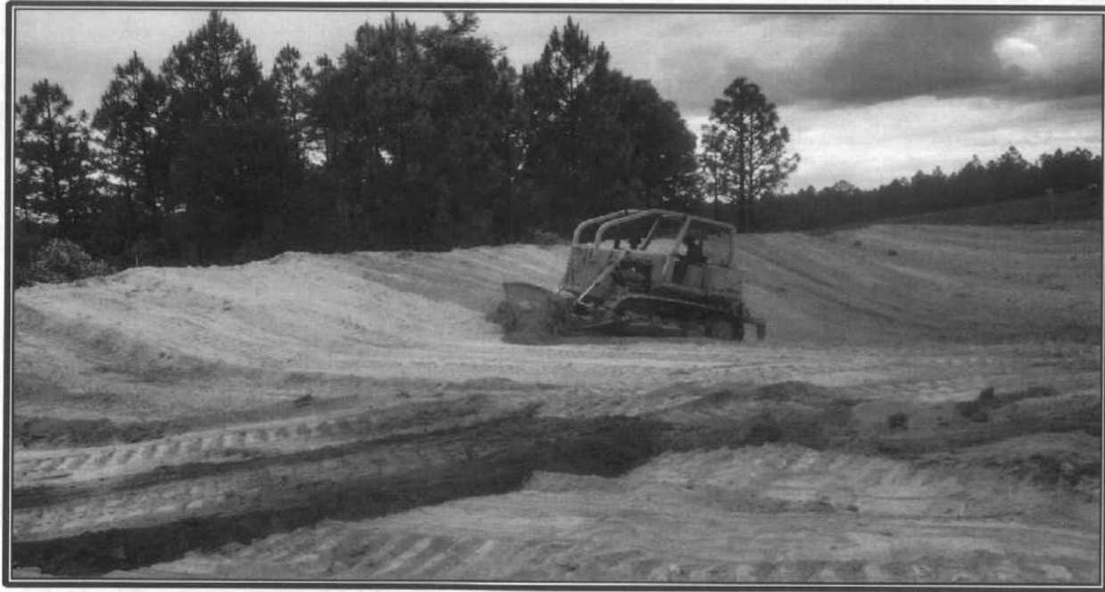
CONSTRUCCIÓN DE BORDO DE ABREVADERO POB. LOS LOBOS
