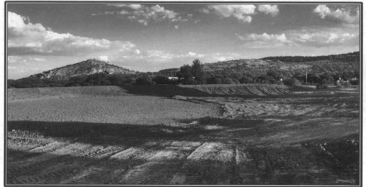
REHABILITACIÓN DE BORDO DE ABREVADERO POB. VICENTE SUAREZ
