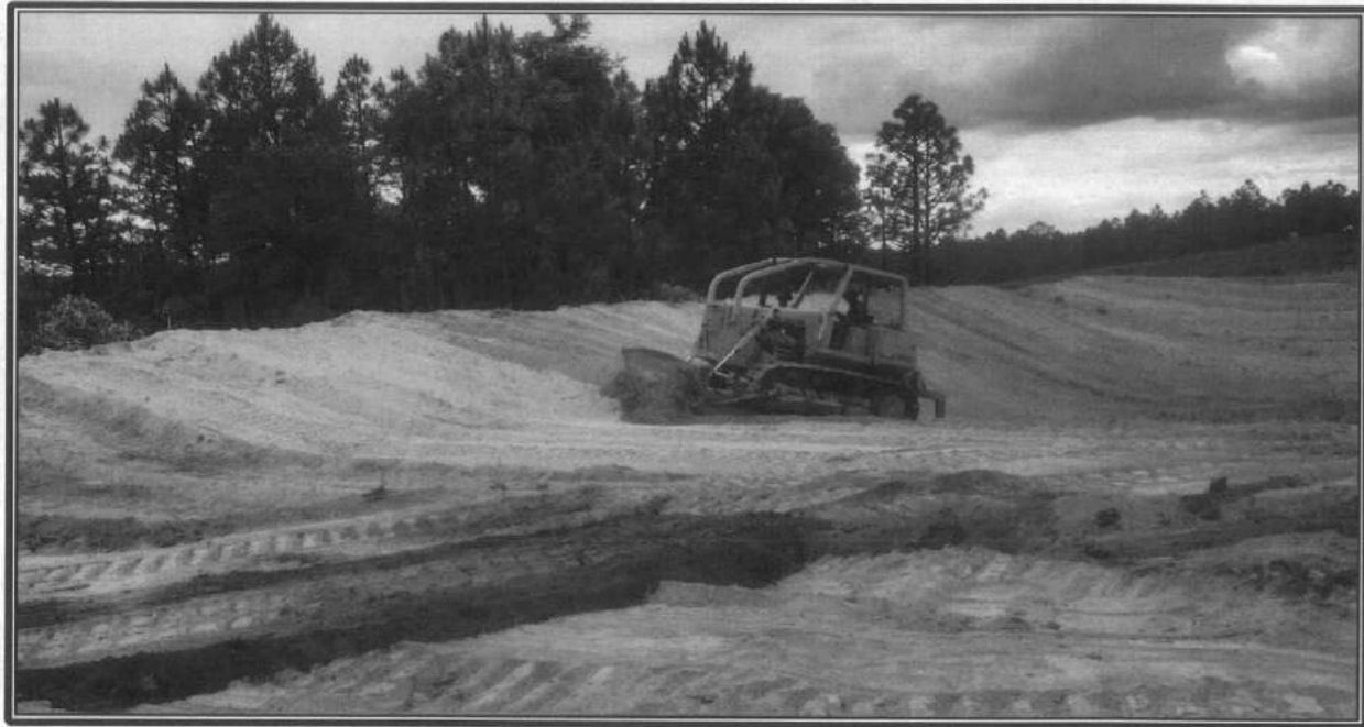
CONSTRUCCIÓN DE BORDO DE ABREVADERO POB. LOS LOBOS
