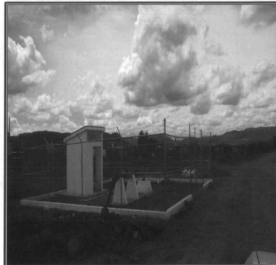
SISTEMA DE AGUA POTABLE, EQUIPAMIENTO DE POZO PROFUNDO, DESCARGA HIDRÁULICA, LÍNEA DE CONDUCCIÓN, CERCO DE PROTECCIÓN, ELECTRIFICACIÓN, CASETA DE CLORACIÓN
